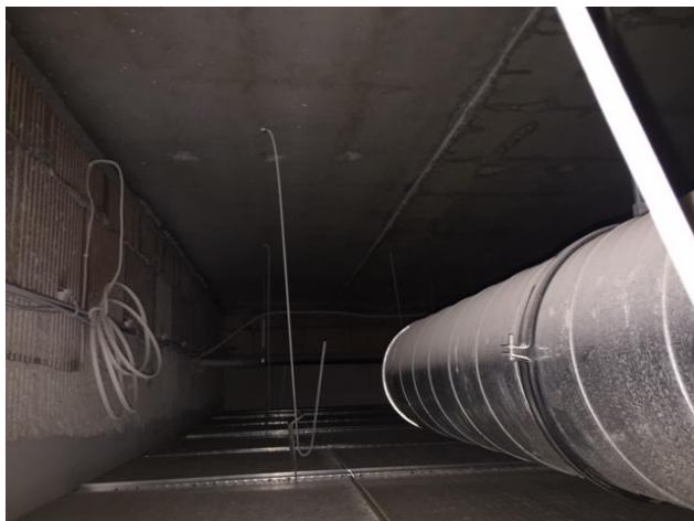
Foto nr OST-7: Widok płyty kanałowej przy ścianie wewnętrznej w miejscu wykonywania nowego otworowania
