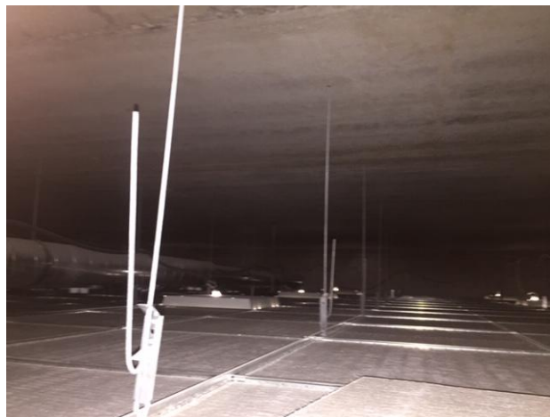
Foto nr OST-8: Widok układu płyt kanałowej od spodu w przestrzeni sufitu podwieszonego
